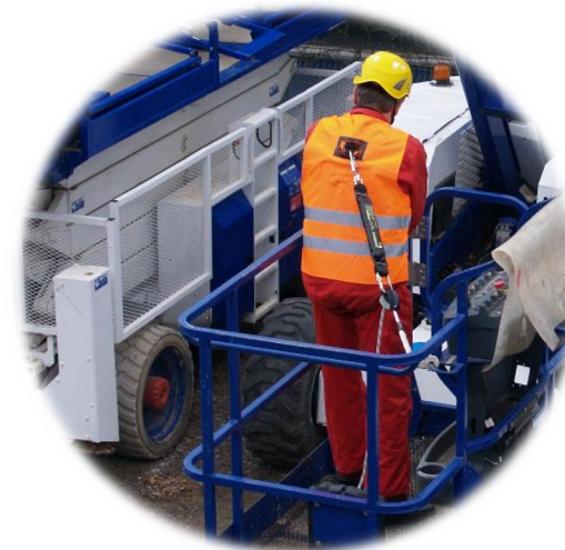
3. Auffangsystem mit mitlaufendem Auffanggerät einschließlich beweglicher Führung
